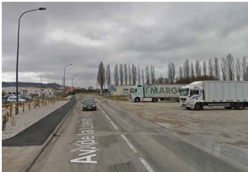
Illustration 56 : Situation avant aménagement d'une voirie desservant une zone d'activités
