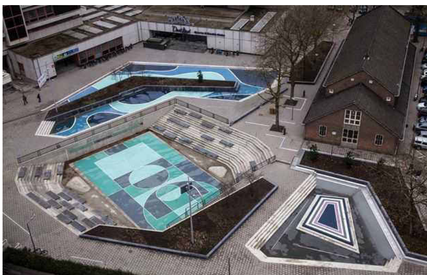
Illustration 50 : Vue aérienne du « Water square » Benthemplein à Rotterdam Crédit image : Le Médiateur
