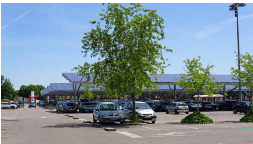
Illustration 16 : Couverture de parc de stationnement en surface par des ombrières photovoltaïques
