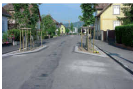
Illustration 30 : Écluses simples plantées avec rétrécissement axial remplissant parfaitement sa fonction de réduction de vitesse
