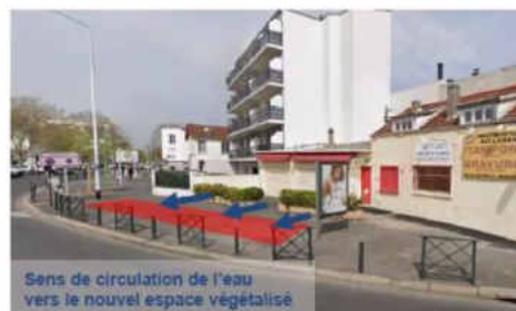
Fosse 3 – zone désimperméabilisée (© Ville de Nanterre – 2020)
