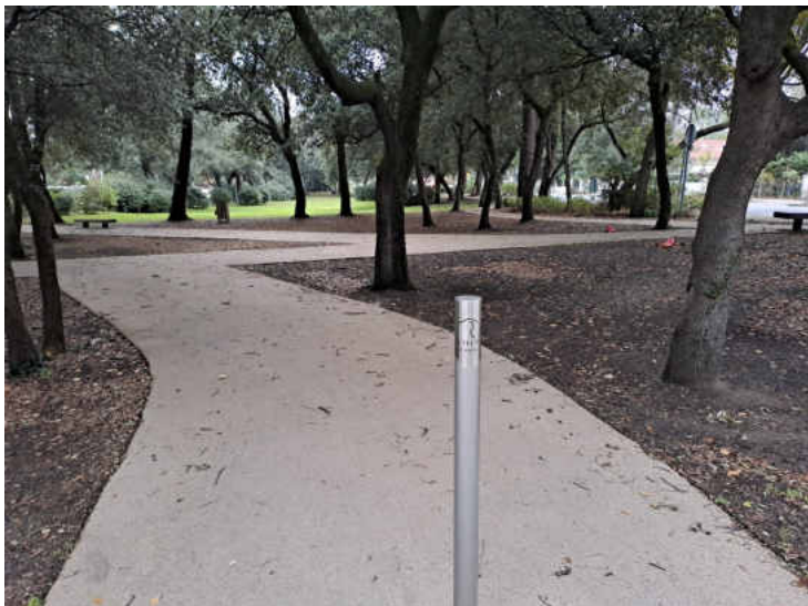
Illustration 59 : Place Meller au Pyla, bitume remplacé par un liant végétal Source : Eiffage Route
