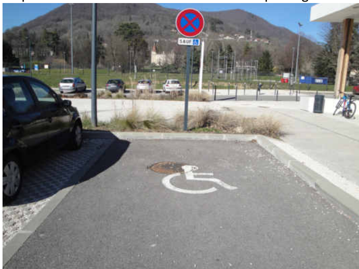
Illustration 109 : Place PMR en enrobés au sein d'un parc de stationnement revêtu en dalles alvéolaires
