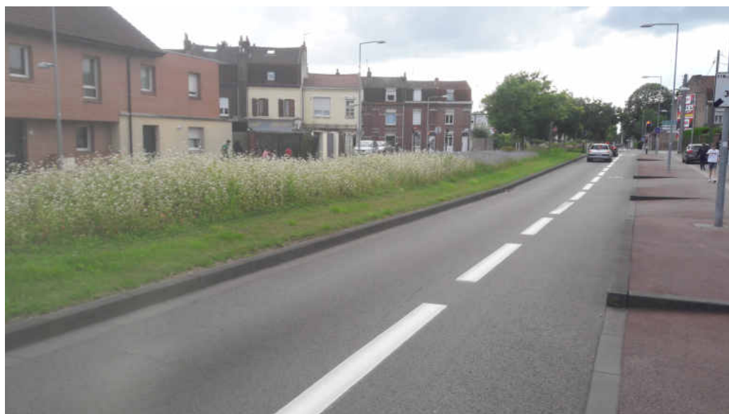
Illustration 105 : Végétalisation de terre-plein central
