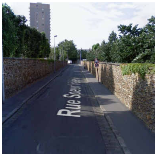
Situation de la voirie avant aménagement : la linéarité de la rue contribuait à des vitesses importantes malgré la présence de dispositifs de limitation des vitesses (source : Google maps)
