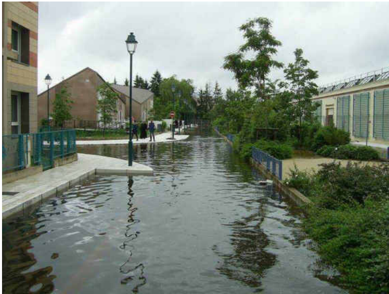
Illustration 51 : Une chaussée inondée dans le quartier Matra à Romorantin.
