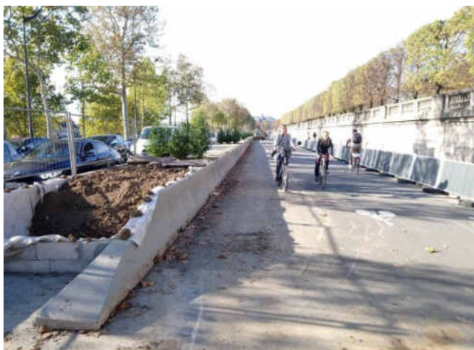
Installation de séparateurs végétalisés Crédit photo : Léon Garaix
