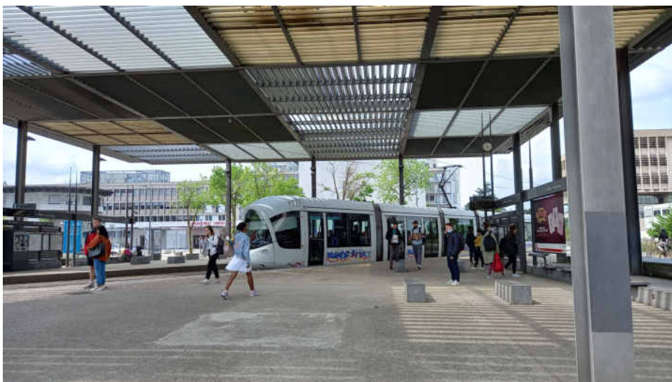
Illustration 95 : Vaste ombrière judicieusement installée au sein de ce pôle d'échanges multimodal
