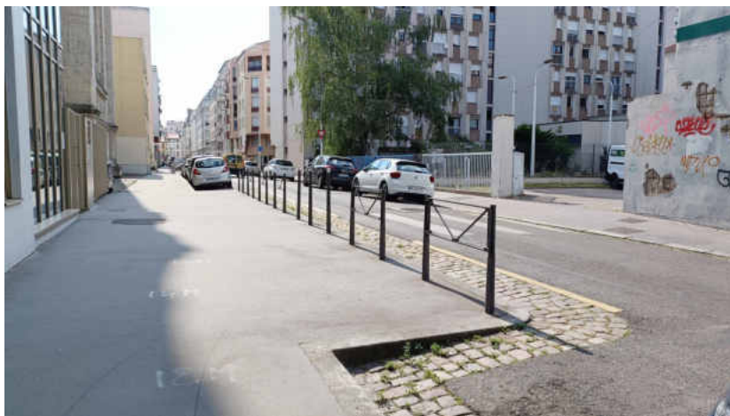
Illustration 24 : Avancées de trottoir offrant des opportunités d'emprise pour la végétalisation
