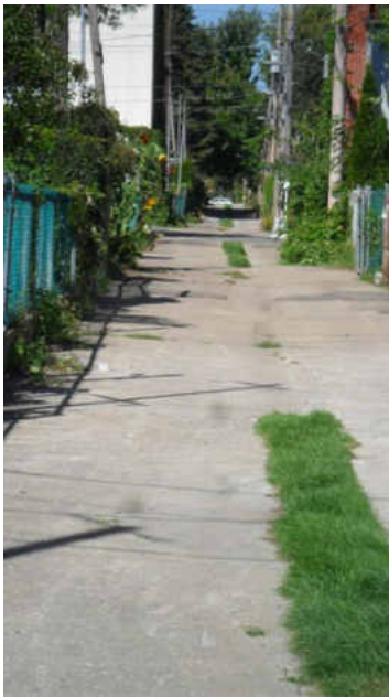
Illustration 80 : Débitumisation et enherbement de la partie axiale de la chaussée correspondant à la partie la moins sollicitée par les véhicules motorisés en circulation Crédit photo : YMCA Pointe-Saint-Charles
