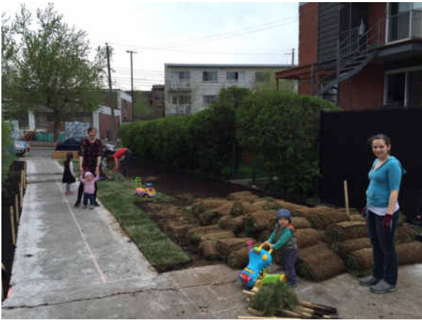
Illustration 79 : Débitumisation et engazonnement d'une portion de ruelle de l'écoquartier Rosemont-la-Petite-Patrie Crédit photo : Écoquartier Rosemont-la-Petite-Patrie
