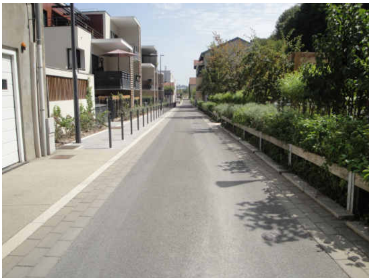
Illustration 41 : Noue plantée mise en place le long d'une chaussée peu circulée
