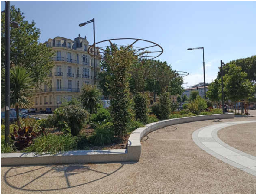
Illustration 20 : Structures porteuses de plantations grimpantes réalisées par les services de la ville sur la place Cayrol à Perpignan (66)
