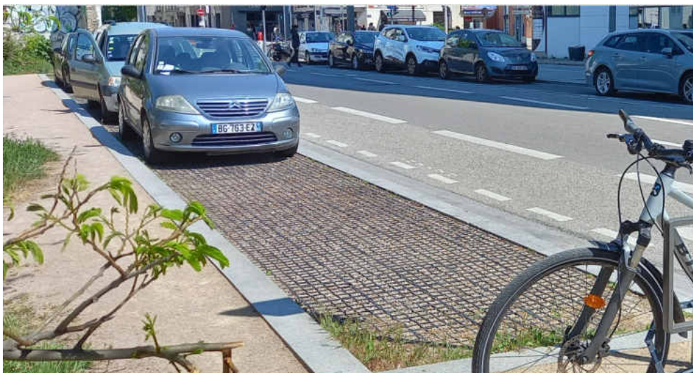
Illustration 110 : Dalles PVC alvéolées avec remplissage gravier sur bande de stationnement
