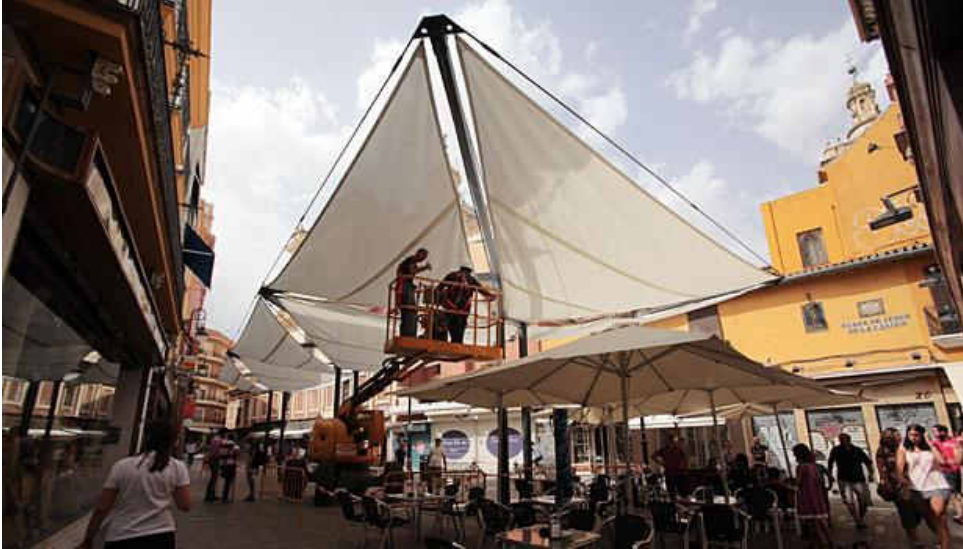
Illustration 19 : Installation d'un voile d'ombrage à l'aplomb de la Plaza del Pan à Séville (Espagne) suite à la demande des commerçants
