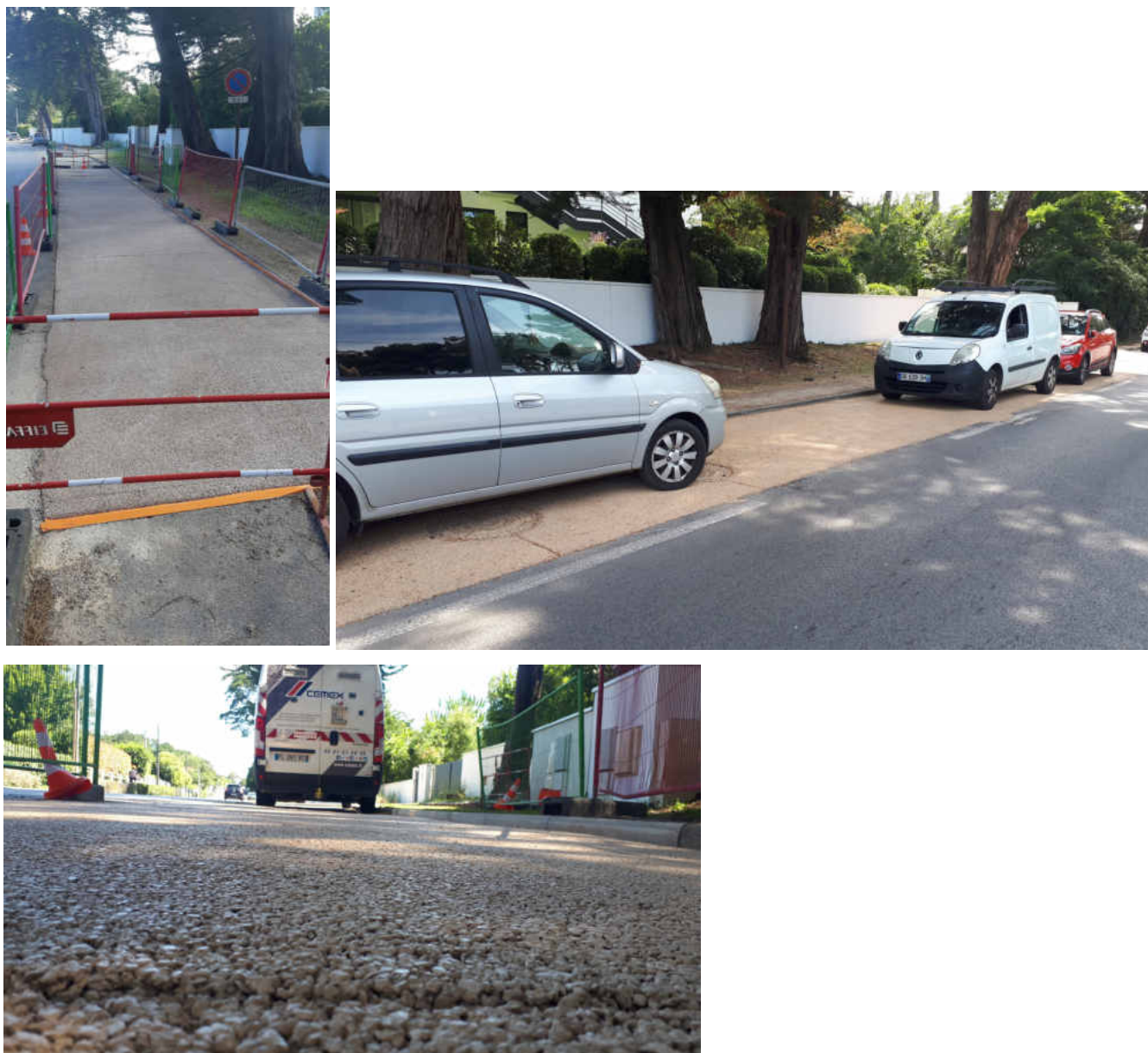
Illustration 113 : Béton perméable sur un site pilote de places de stationnement en voirie Crédit photo : Nora Laichour – Cemex
